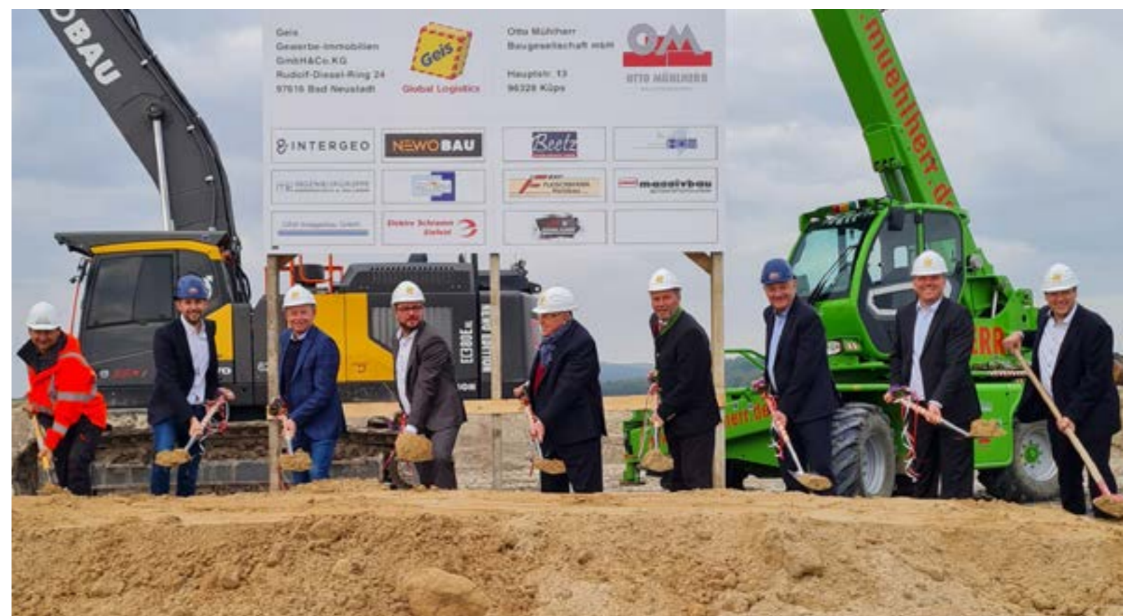
Zahájení stavby v Ebersdorfu v říjnu 2022.
